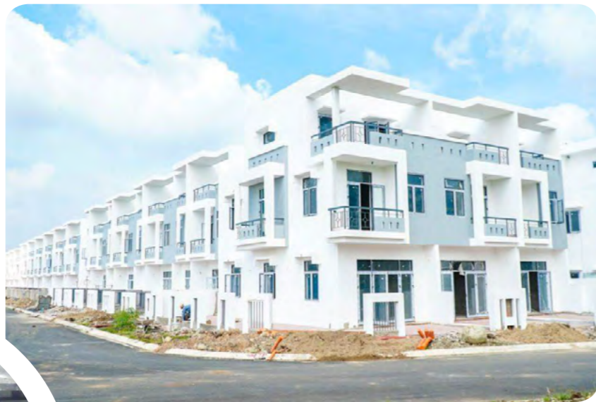
CÔNG TRÌNH GIANG ĐIỀN
