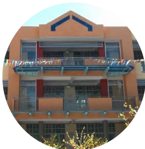
CÔNG TRÌNH THI CÔNG NGUYỄN VĂN TRỖI
