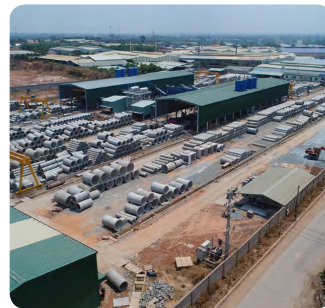
XN CỐT BÊ TÔNG
